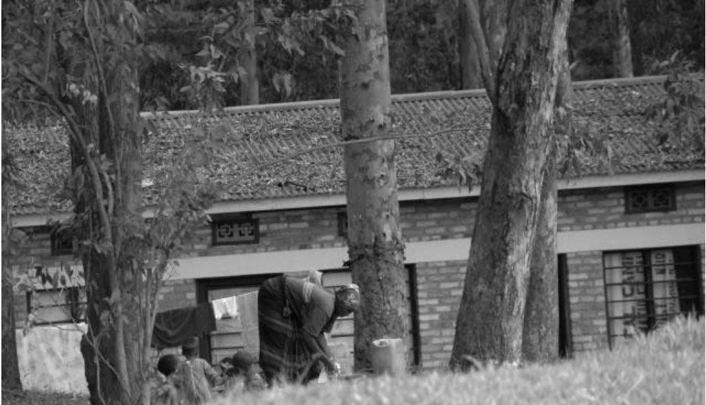
▲ 창살이 설치된 주택
